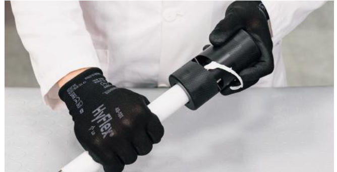
29. attēls — pārklājuma noņemšana (steelPRES ar PP pārklājumu)
