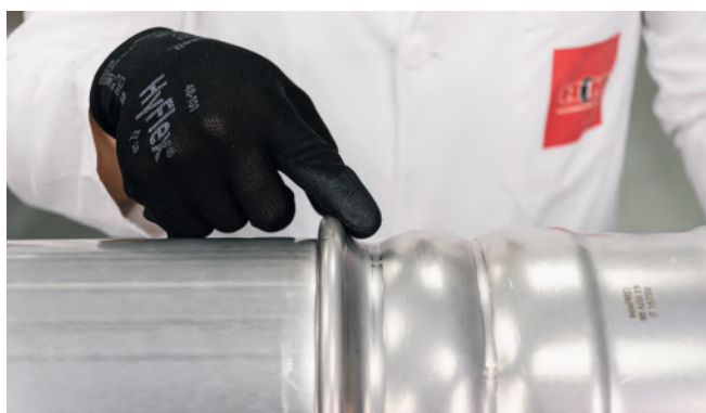
36.attēls – lielo izmēru cauruļu un veidgabalu presēšanas pārbaude
